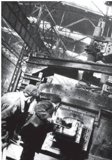
Рис. 45. Электропечь имени Косарева на Уралмашзаводе. СССР на стройке. 1932. № 7.
